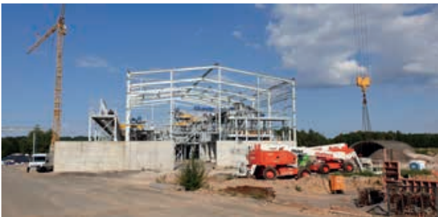
Baustelle der Johann Schirmbeck Glasrecycling GmbH im Gewerbepark Sembach im Juli 2020
