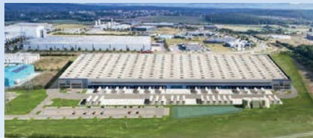
Geplante Logistik-Immobilie im IG Nord, Fertigstellung noch 2020 geplant
